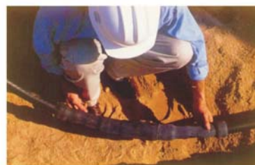
3. 再裝上QS III的外被套管或用防水橡皮膠帶1/2重疊予以包覆
