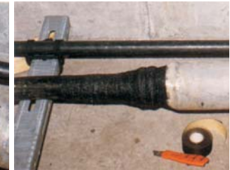
自然固化後即完成
